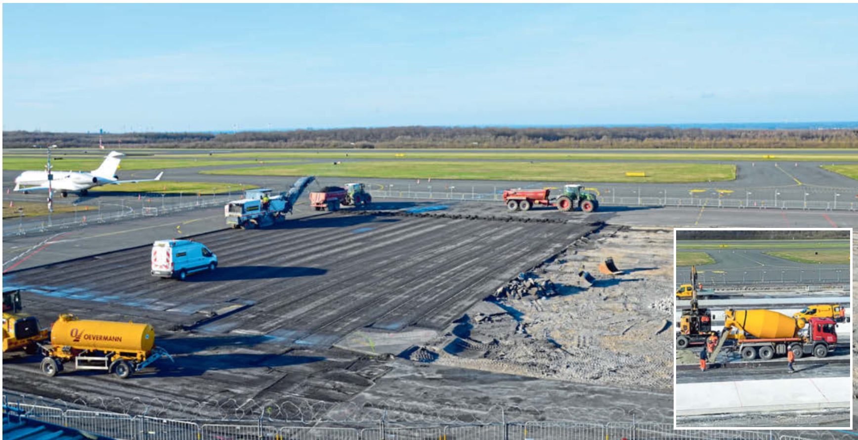
Das Vorfeld des Airports Paderborn/Lippstadt wird derzeit von Grund auf erneuert. Dabei werden auch Betonmischer eingesetzt (kl. Foto).
